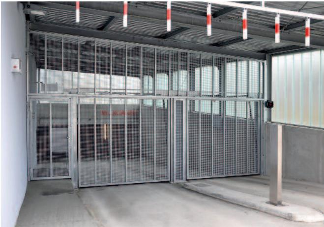
Feuerverzinkte Toranlage mit Nebentüre und Sturzverkleidung
