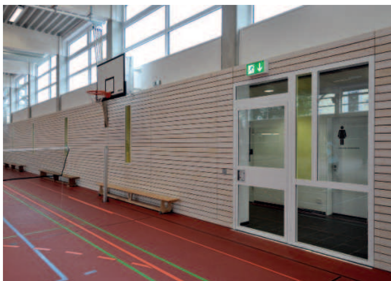
Ballwurfsichere Stahl-Glastüre für die Sporthalle
