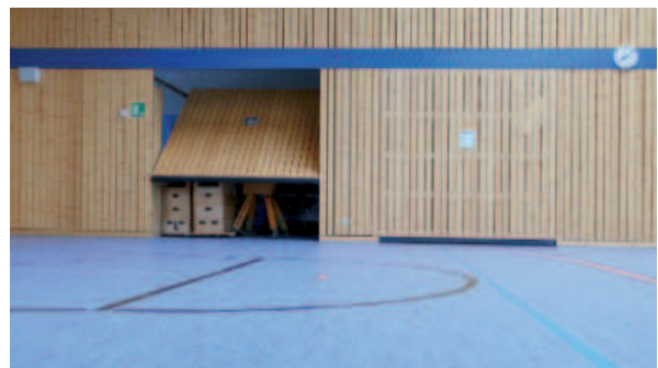
Geräteraumtore mit Fichte Glattkantprofilen
