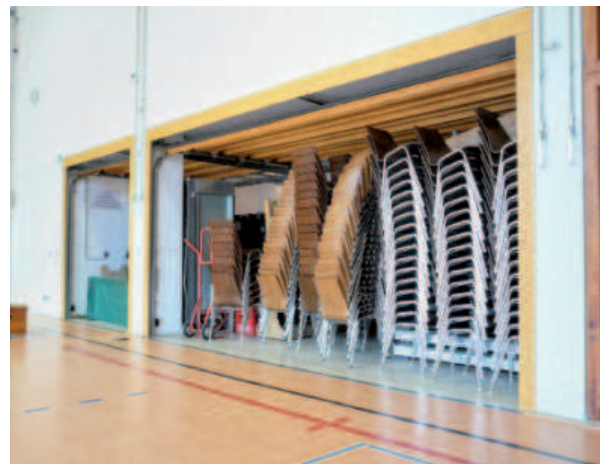
Das Sektionaltor öffnet senkrecht nach oben
