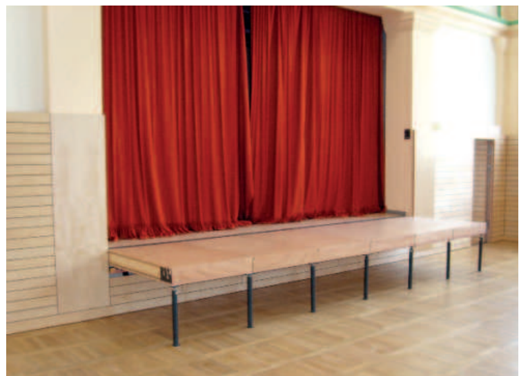
Kraftabbauende und ballwurfsichere Klappbühne
