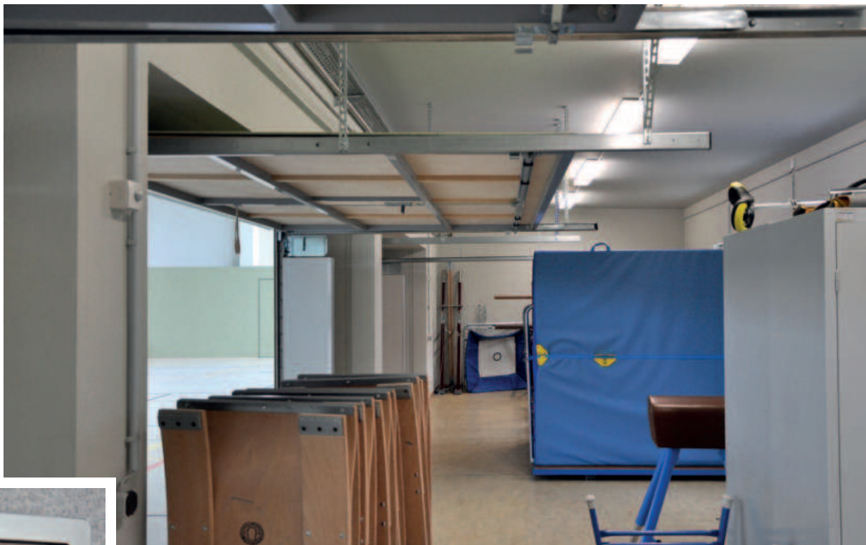
Die lichte Durchgangshöhe wird beim geöffneten Torblatt auch unter den Laufschiene eingehalten
