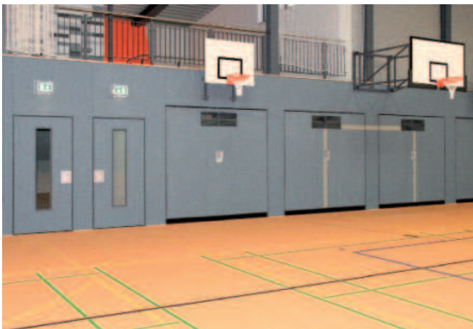
Geräteraumtore und Turnhallentüren mit textilem Prallbelag
