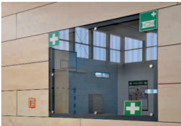
Kraftabbauendes Regieraumfenster mit Glaspunkthaltern
