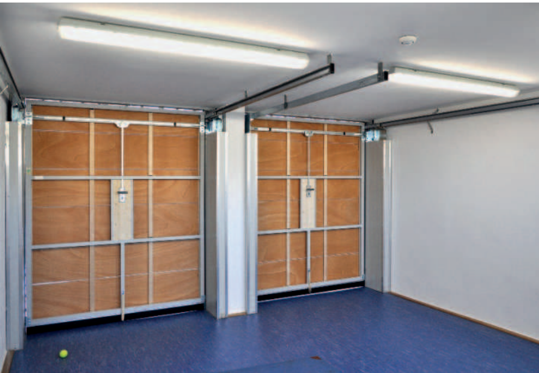
Geräteraumtore mit zwei-Punkt-Verriegelung und gefederten Schließriegeln
