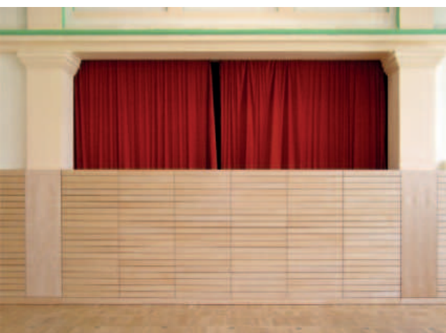
Kraftabbauende und ballwurfsichere Klappbühne
