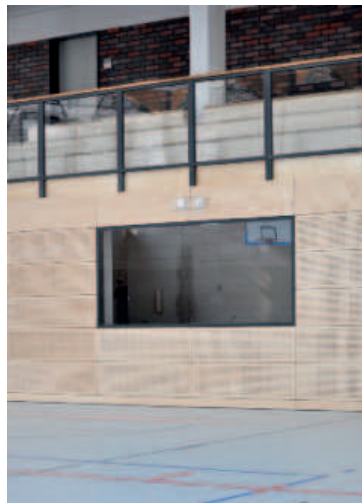
Kraftabbauendes Regieraumfenster als Stahlrahmen-Glaskonstruktion
