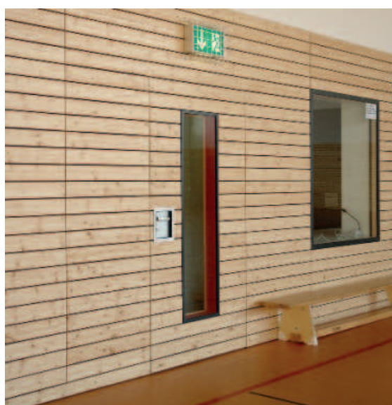
Sporthallentüren als Brandschutztür mit Rauchschuttfunktion T-30 RS
