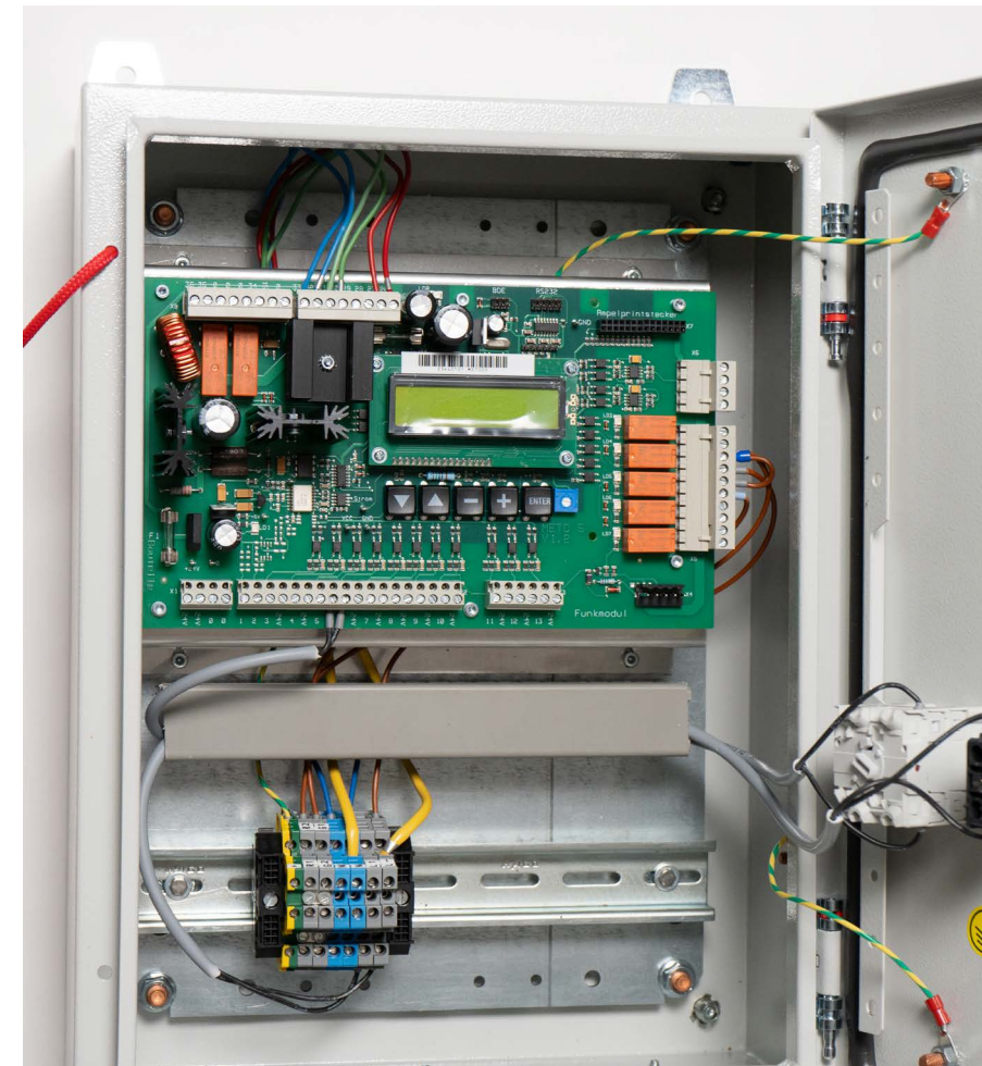
TS 24/ E Externe Steuerung
