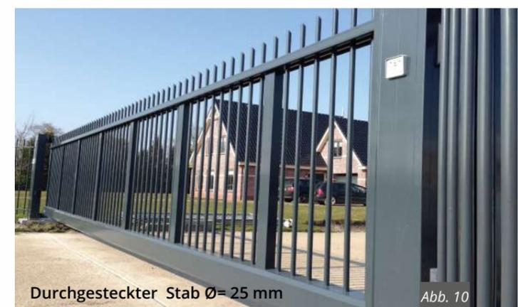
Durchgesteckter Stab Ø= 25 mm
