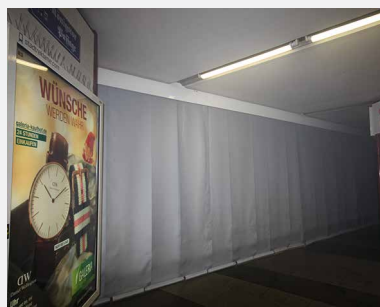
U-Bahn Hauptbahnhof Nürnberg geschlossener Zustand
